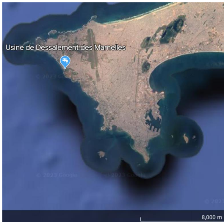
Figure 0.1: Usine de Dessalement des Mamelles on the Cap-Vert peninsula. Source: Google Earth
